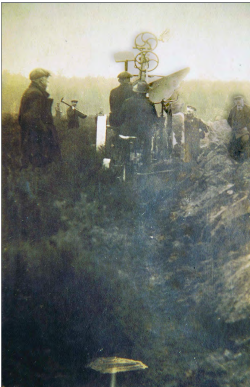
Heiploeg aan het werk tijdens ontginningwerken. (Fotoarchief heemkundige kring Hechtel-Eksel)
