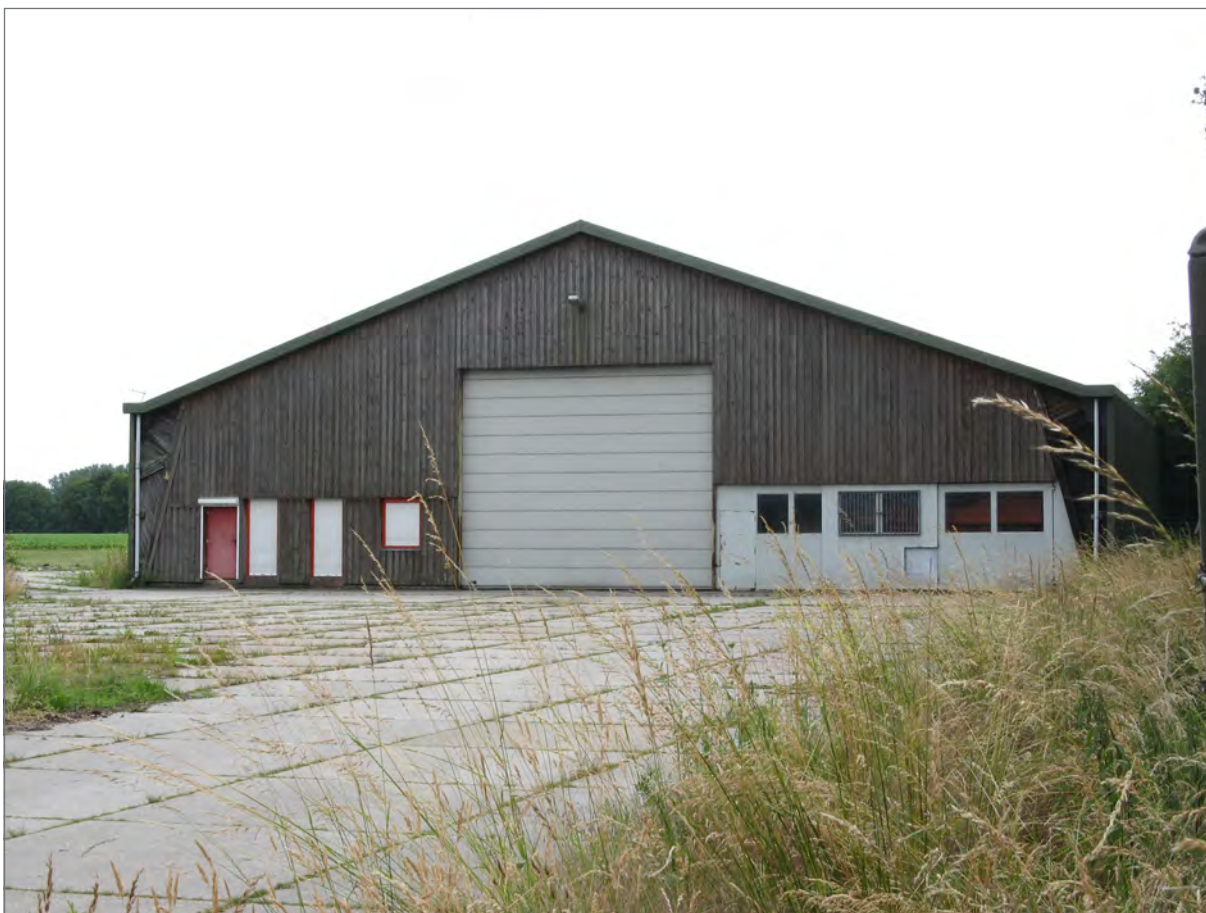
De loods van de voormalige houthandel Van Duffel te Eksel, langs de oostelijke kant van de verdwenen spoorweg en station te Eksel (foto juli 2013).
